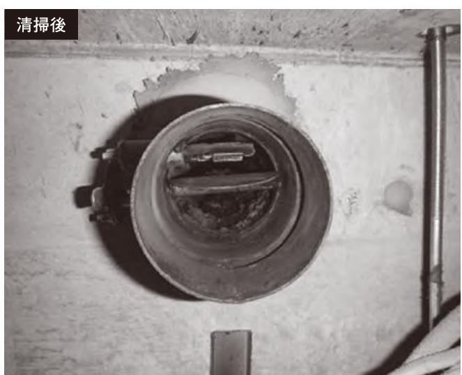
写真7 排気ファイアダンバ
